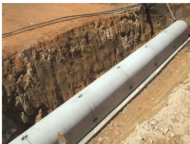
⑩施工完了
