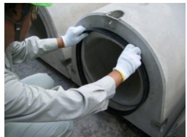
⑥ジョイントゴムの挿入
