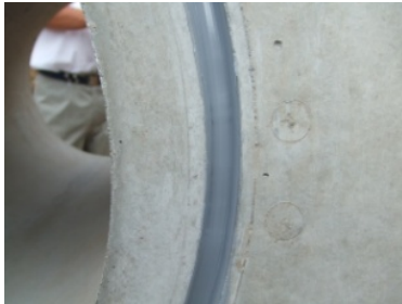
⑤接着剤の均しと充填確認
