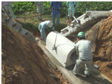
②製品据付け
